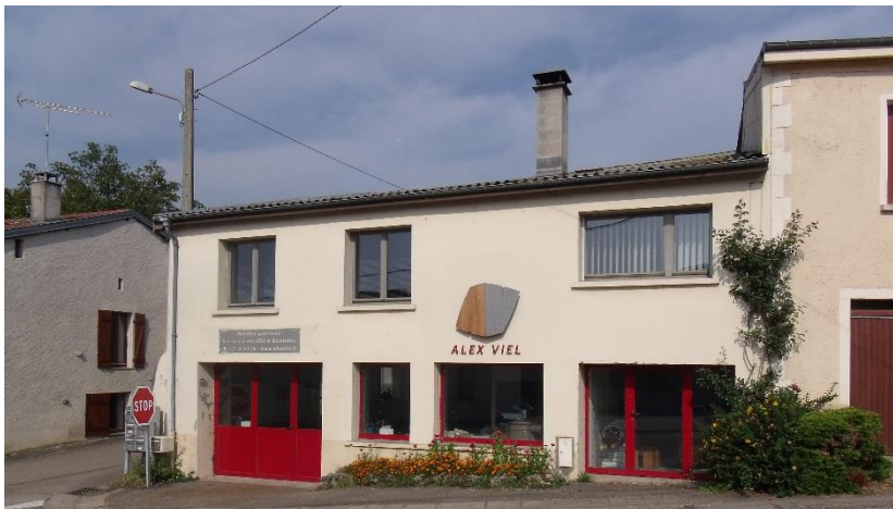
Entreprise Viel à Germonville
