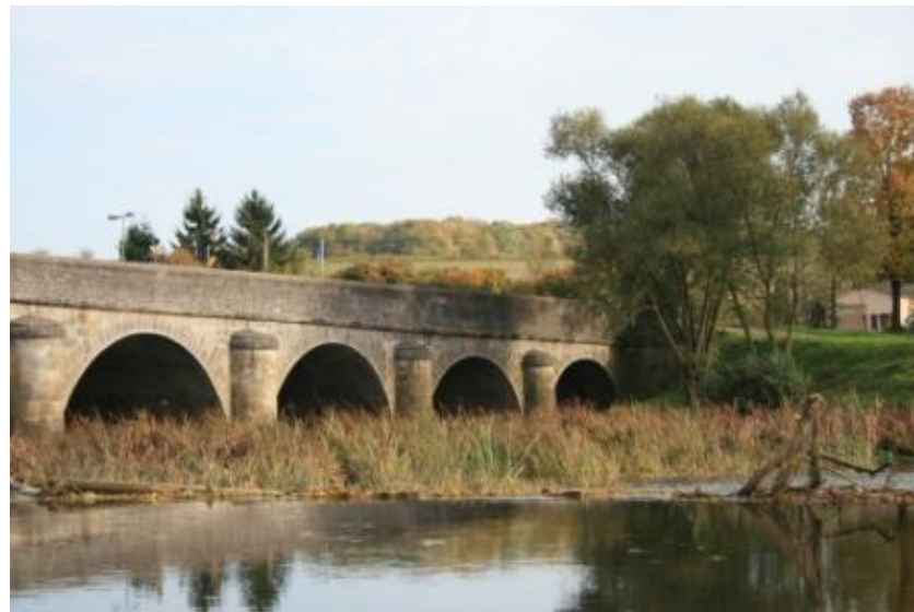
Pont sur le Madon à Xirocourt – Crédit UGC
