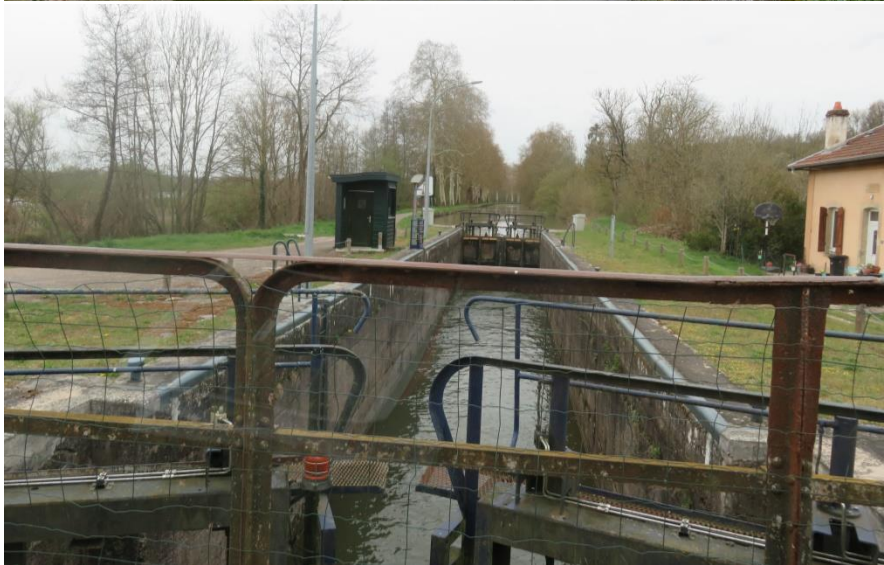
Exemples d'obstacles à l'écoulement des eaux : un ruisseau canalisé et une écluse (source : Even conseil)
