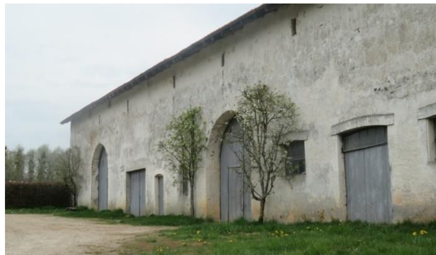
Ancien corps de ferme rénové à Bainville-aux-Miroirs (source : Even conseil)
