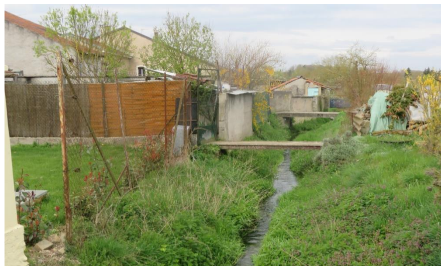
Exemples de cours d'eau peu valorisés en centre-bourg, bien que végétalisés (source : Even conseil)
