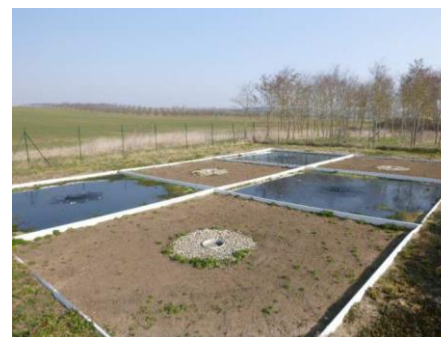
Station d'épuration de Saint-Firmin
